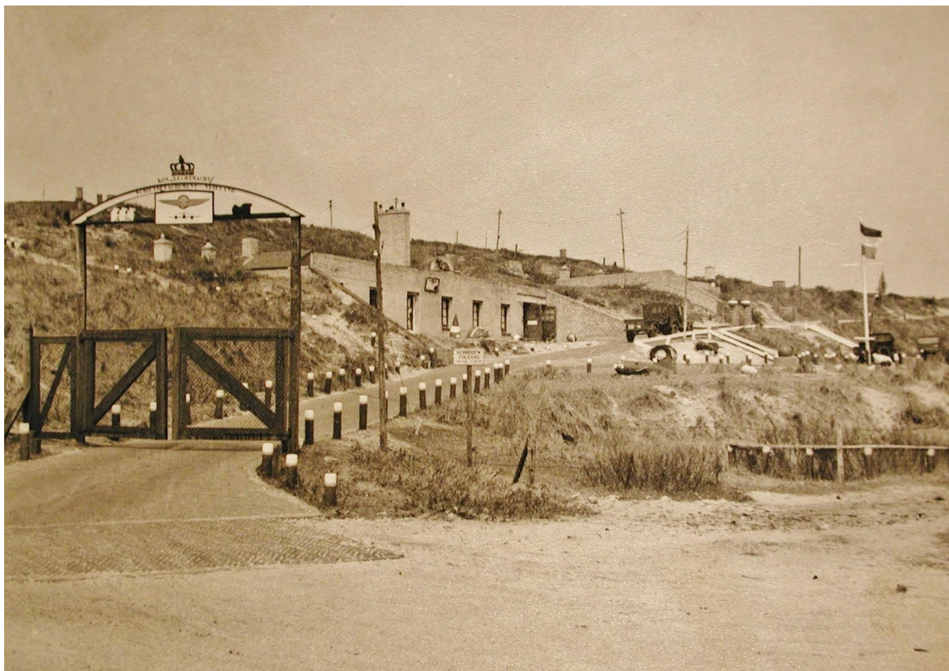
Oostbatterij met zicht op de keukenbunker (omstreeks 1955)
