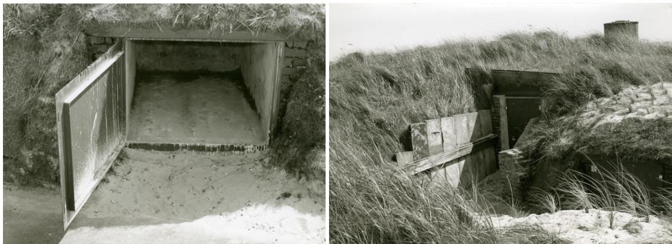
Nieuwe ijzeren deur in munitienis en de betonnen keerwand bij ingang woonbunker.
