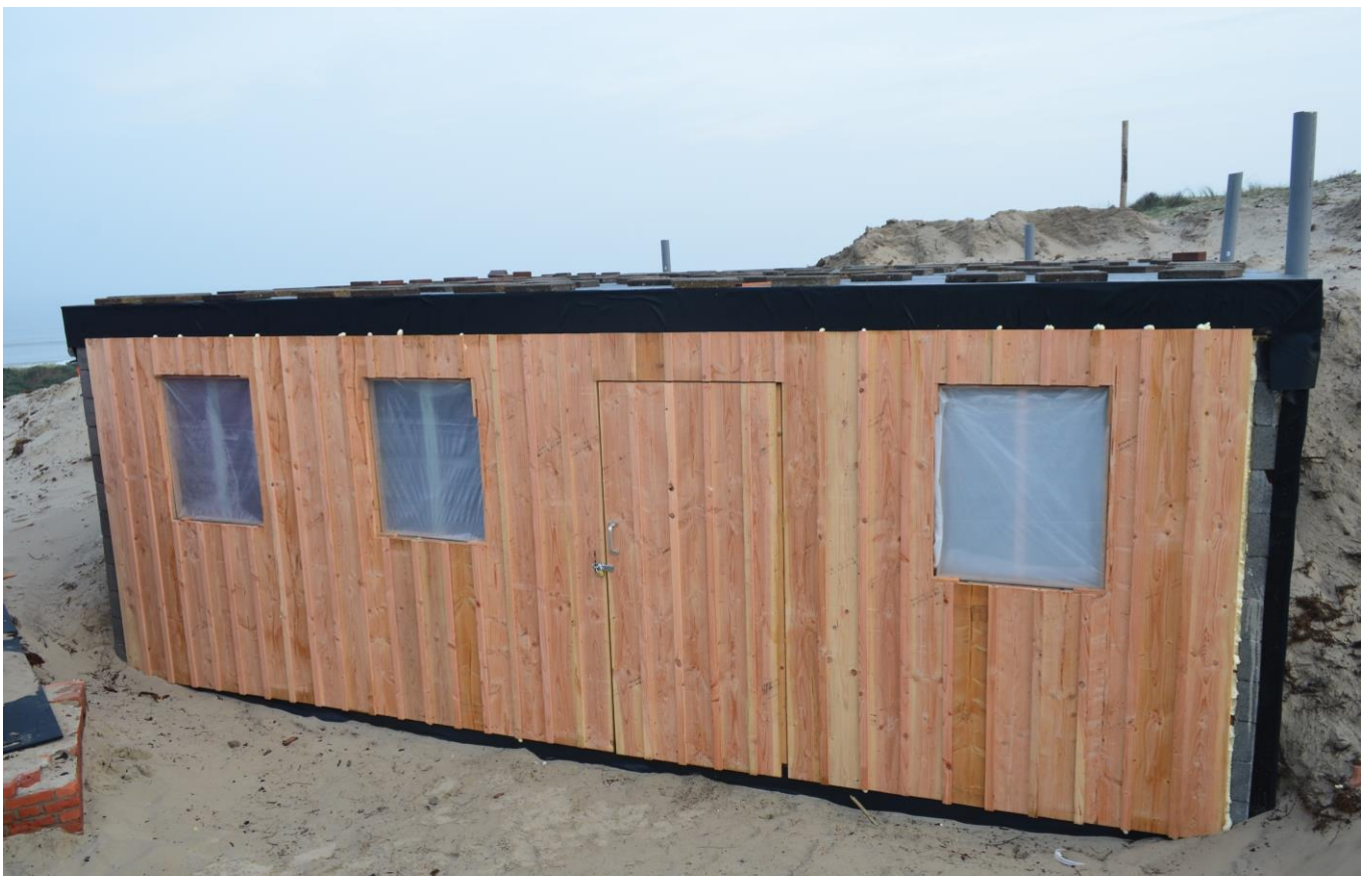
De weer herstelde commandantenbunker.
