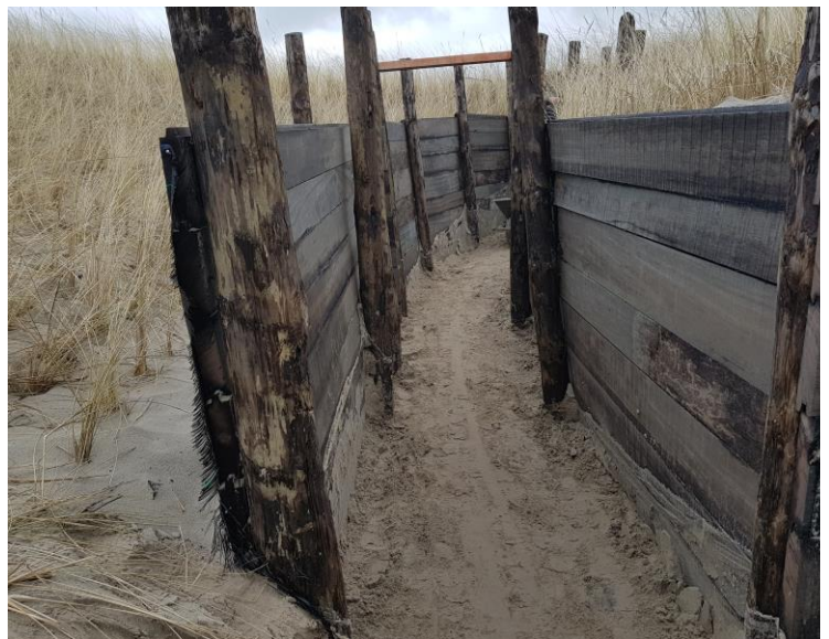
De weer herstelde houten loopgraaf bij de uitgang van de tunnel.
