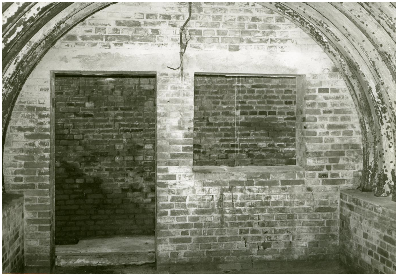
Binnenzijde woonbunker ten noorden van huize De Horn.
