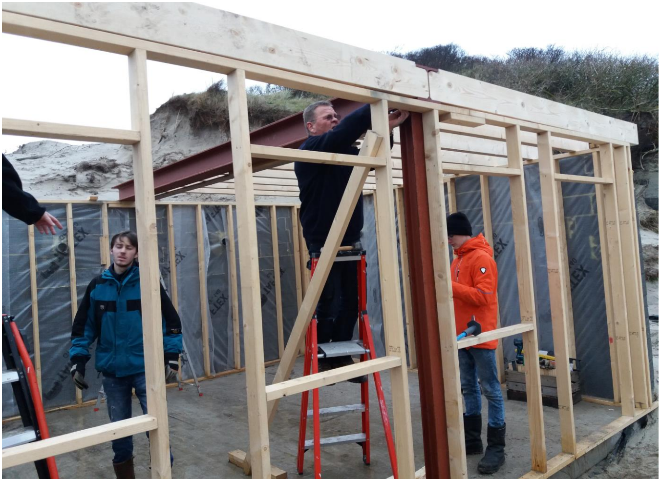
Herstel werkzaamheden aan het houten onderkomen aan de Oost zijde van Stelling 12H.
