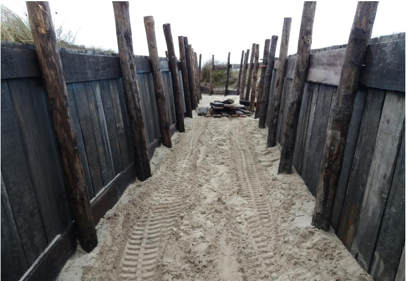
Herstel werkzaamheden aan het houten geschut emplacement.
